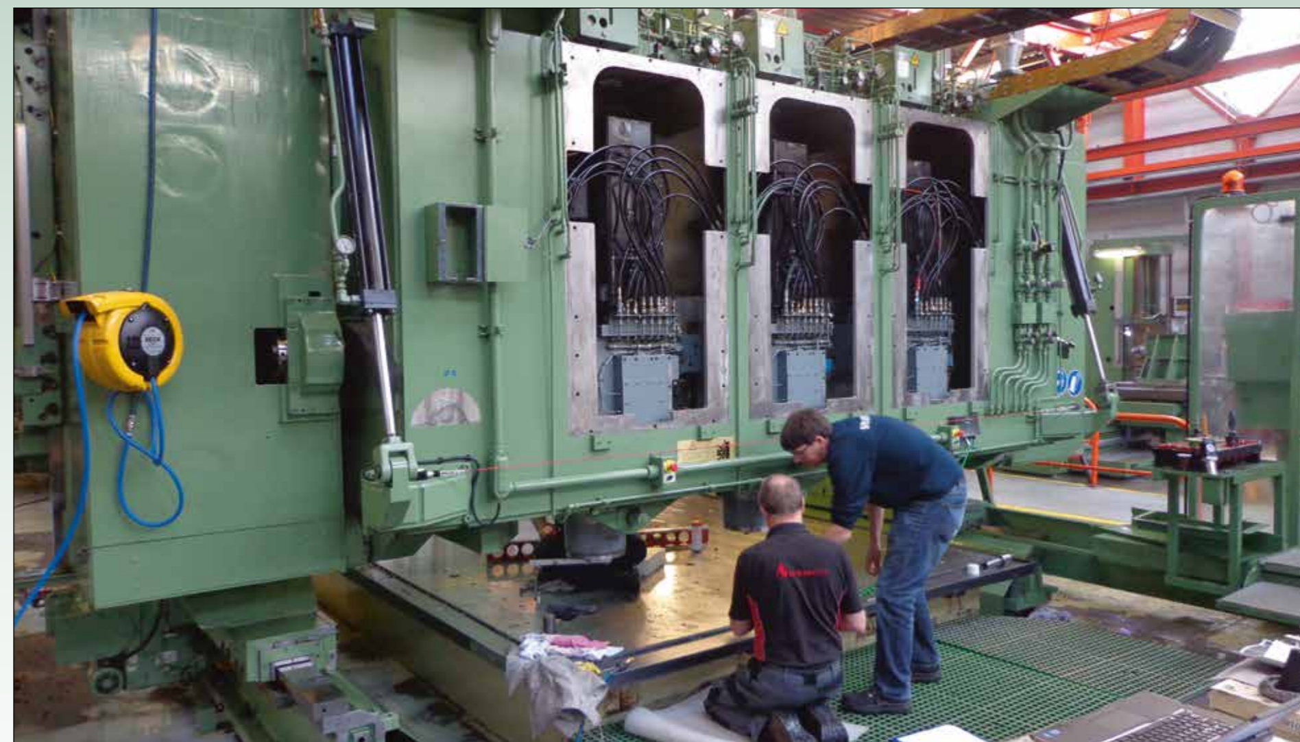
Maintenance-specialisten bezig met een omvangrijke retrofit-operatie.
