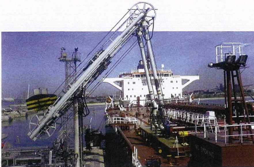
Fluxel doit assurer la fiabilité et la disponibilité d'un grand nombre d'équipements. Parmi eux, les bras de chargement et déchargement. Ces conduites articulées, qui effectuent la liaison entre le navire et les pipelines, jouent un rôle stratégique.
