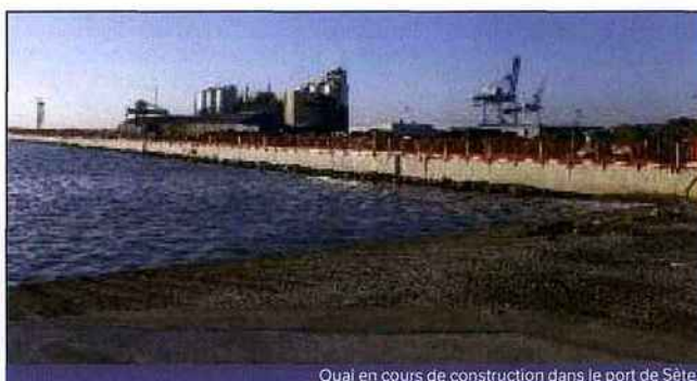
Quai en cours de construction dans le port de Sète.
