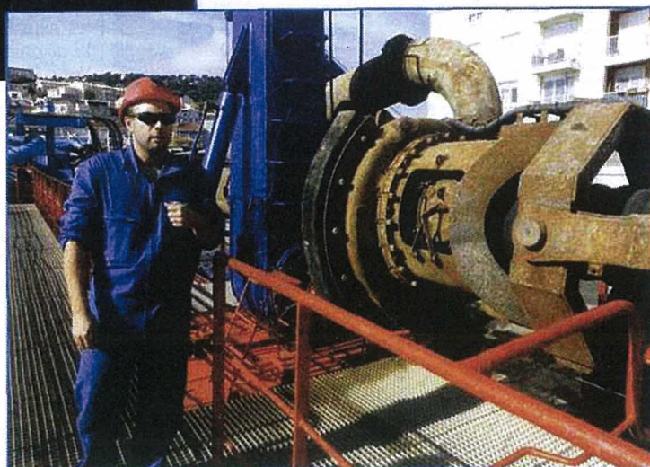
A droite, la pompe de dragage.
