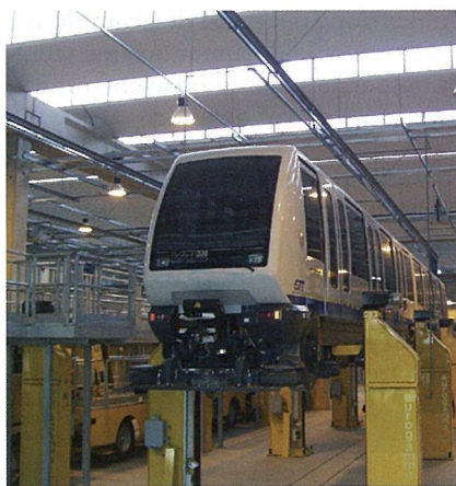
Fig. 2 - Impianto di manutenzione dei veicoli del VAL di Torino in prossimità del posto di comando e controllo (PCC) e del deposito dei veicoli.
