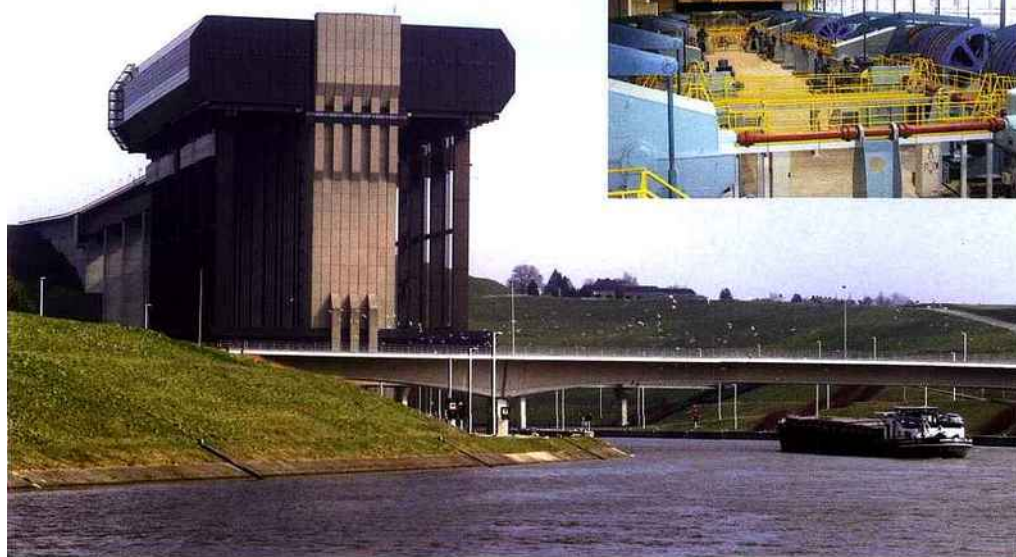
Ci dessus : Rattrapant d'un coup une dénivellation de 73,15 m, l'ascenseur à bateaux de Strépy-Thieu est à ce jour le plus grand du monde. En haut à droite : Vue d'une salle des machines. Au premier plan en rouge, l'arbre de synchronisation qui relie mécaniquement les quatre moteurs assurant les translations.
